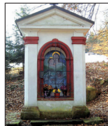
Kaple u Slatinského mostu
