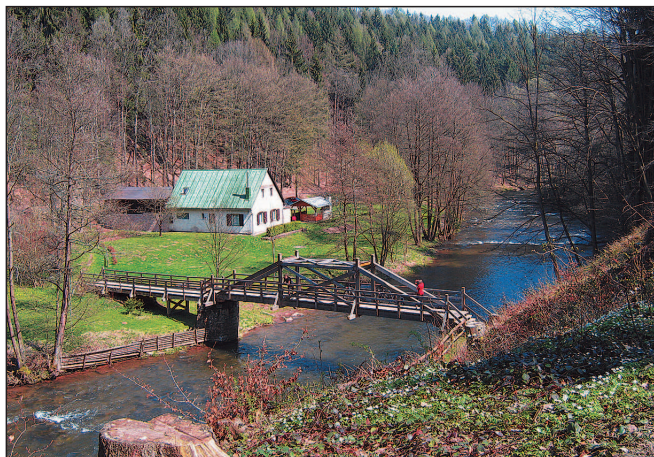
Nově vybudovaná Boušinská lávka
