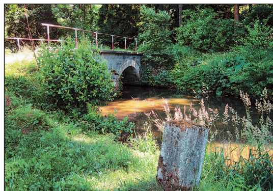
Most přes řeku Metuji v Maršově nad Metují
